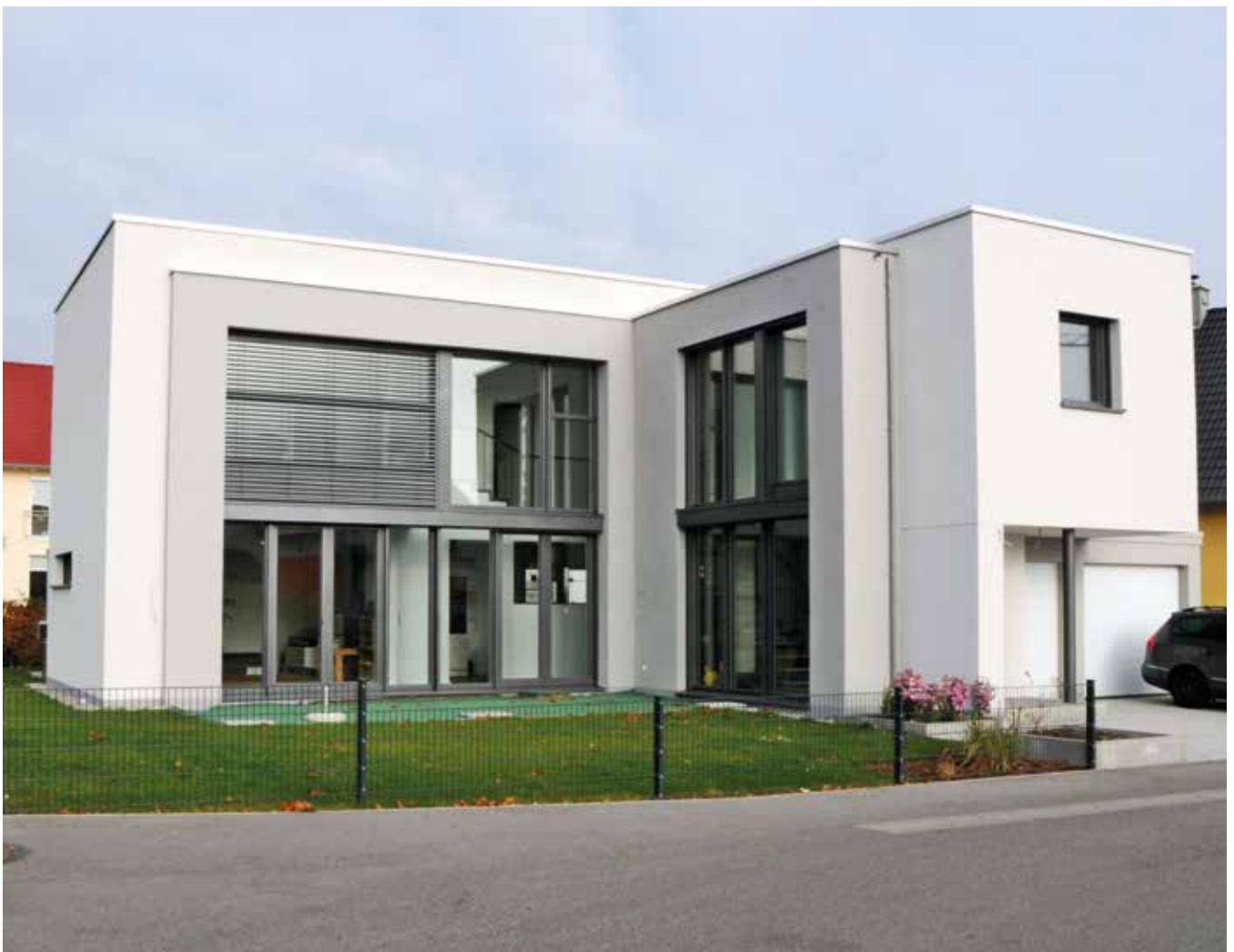
Licht und Energie: Über die großzügige Dreifachverglasung im Südwesten lassen sich Wärmegewinne voll nutzen. Vor Überhitzung schützen Raffstores.
