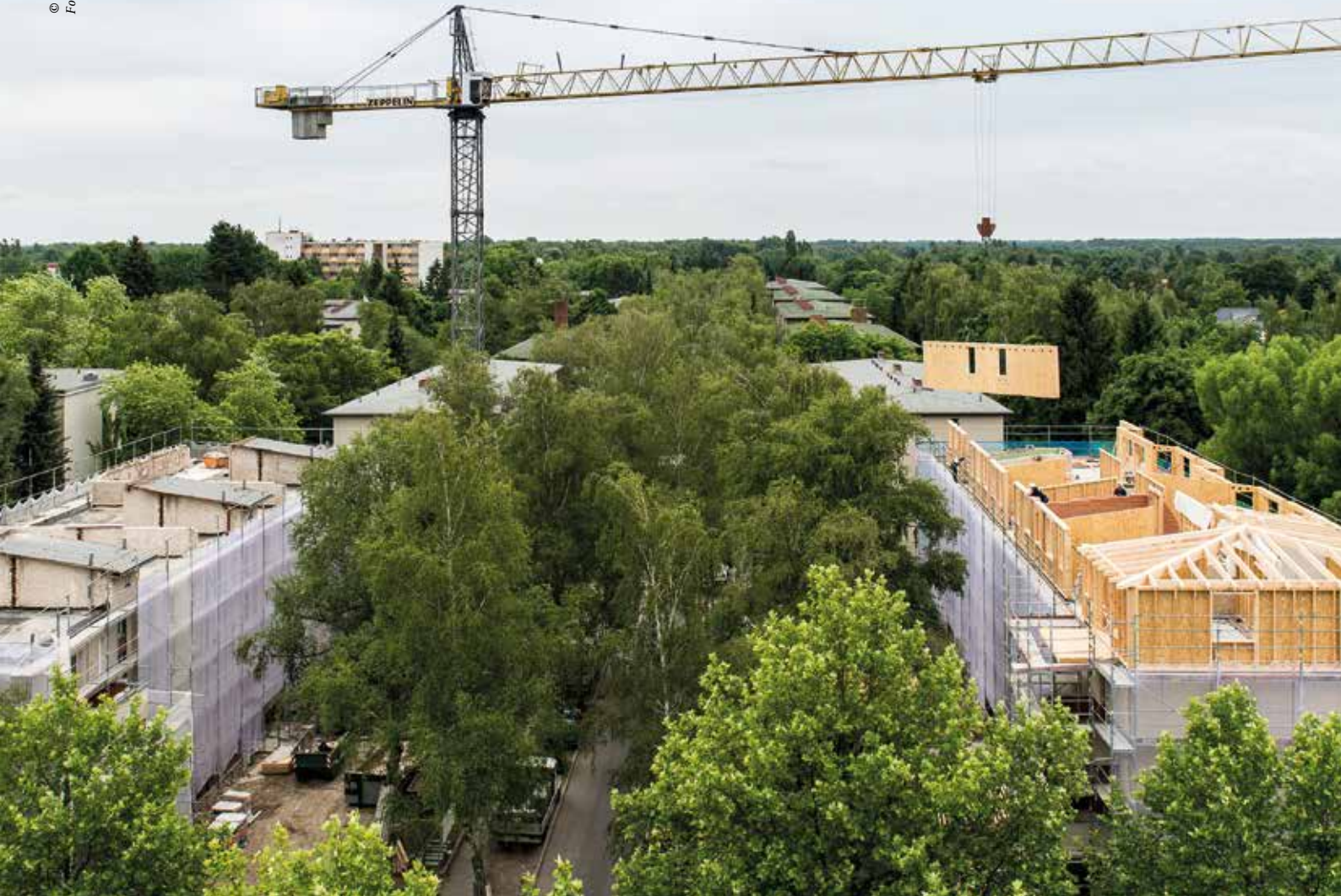
Die Siedlung aus den 1930-er Jahren ist in die Jahre gekommen. Die Gebäude werden energetisch grundlegend überarbeitet. Durch Aufstockung der ehemaligen Dachspeicher wird zusätzlicher Wohnraum geschaffen.
