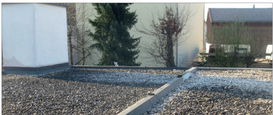
Auswirkung eines Wanderschattens von einem Kamin auf einem Flachdach
