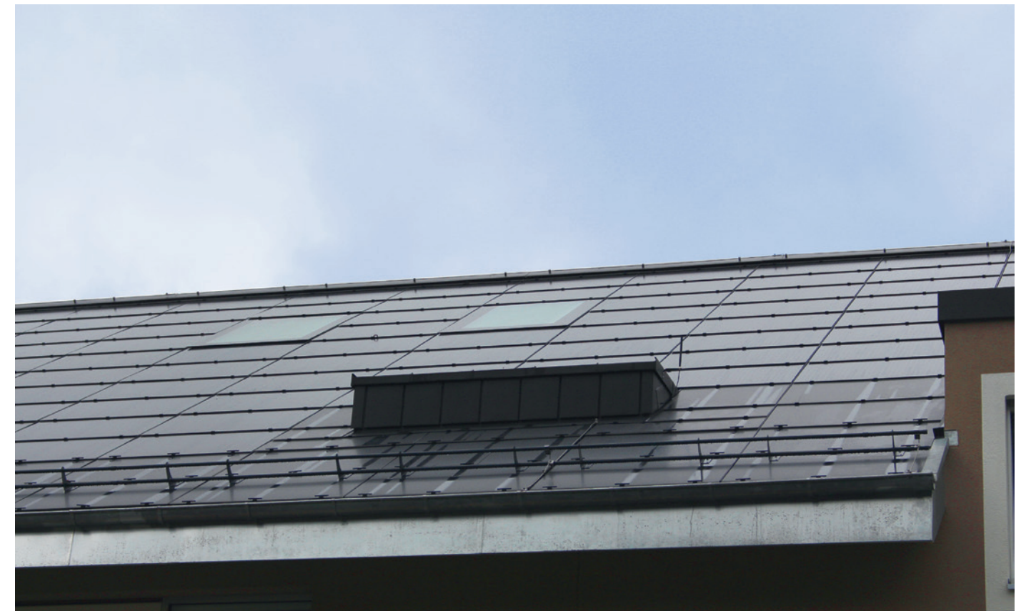
Integrierte PV-Anlage mit Unterdach MENTO 3000 connect
