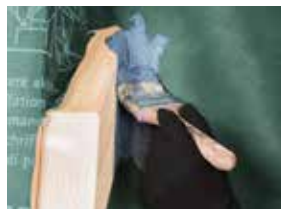
Anschluss Kehlbalken/Sparren mit AEROSANA VISCONN FIBRE und AEROSANA FLEECE
