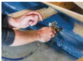
Anschluss an verputzten Drempel
