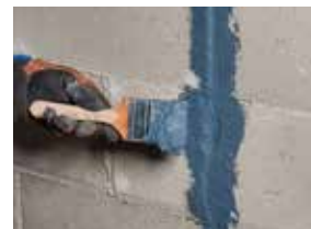
Zustreichen von Rissen bis 20 mm
