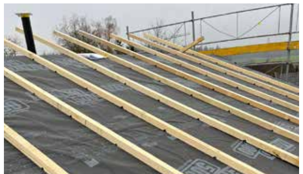
... und der SOLITEX MENTO 5000 connect Unterdachbahn
