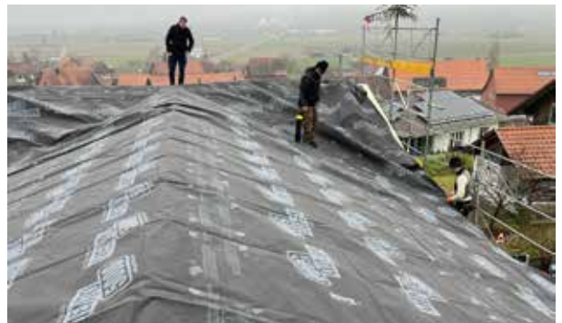
Ausgelegte Unterdachbahn SOLITEX MENTO 5000 connect
