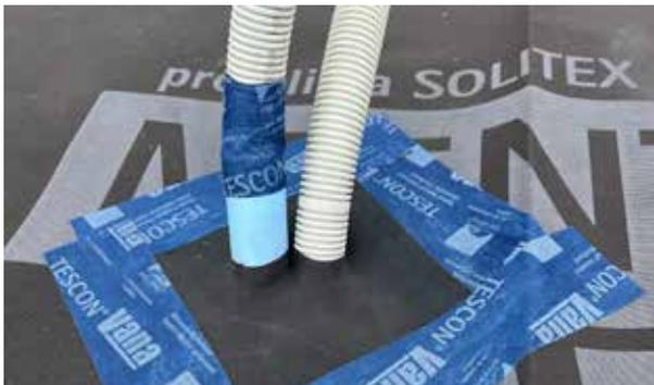
pro clima Manschetten und TESCO VANA Allround Klebenband wurden eingesetzt, um Durchdringungen für Kabelrohre (mit ROFLEX 20 multi) ...
