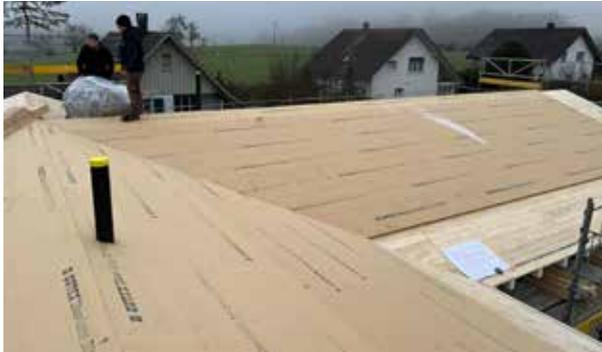
Anlieferung der vorkonfektionierten Platte zum Verlegen auf Holzfaserunterdachplatten
