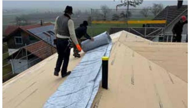
Ausrollen der vorkonfektionierten Platte
