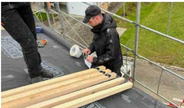
TESCON NAIDECK mono patch Klebe-Pflaster dienen als Nagel-dichtungen zwischen den Konterlatten ...
