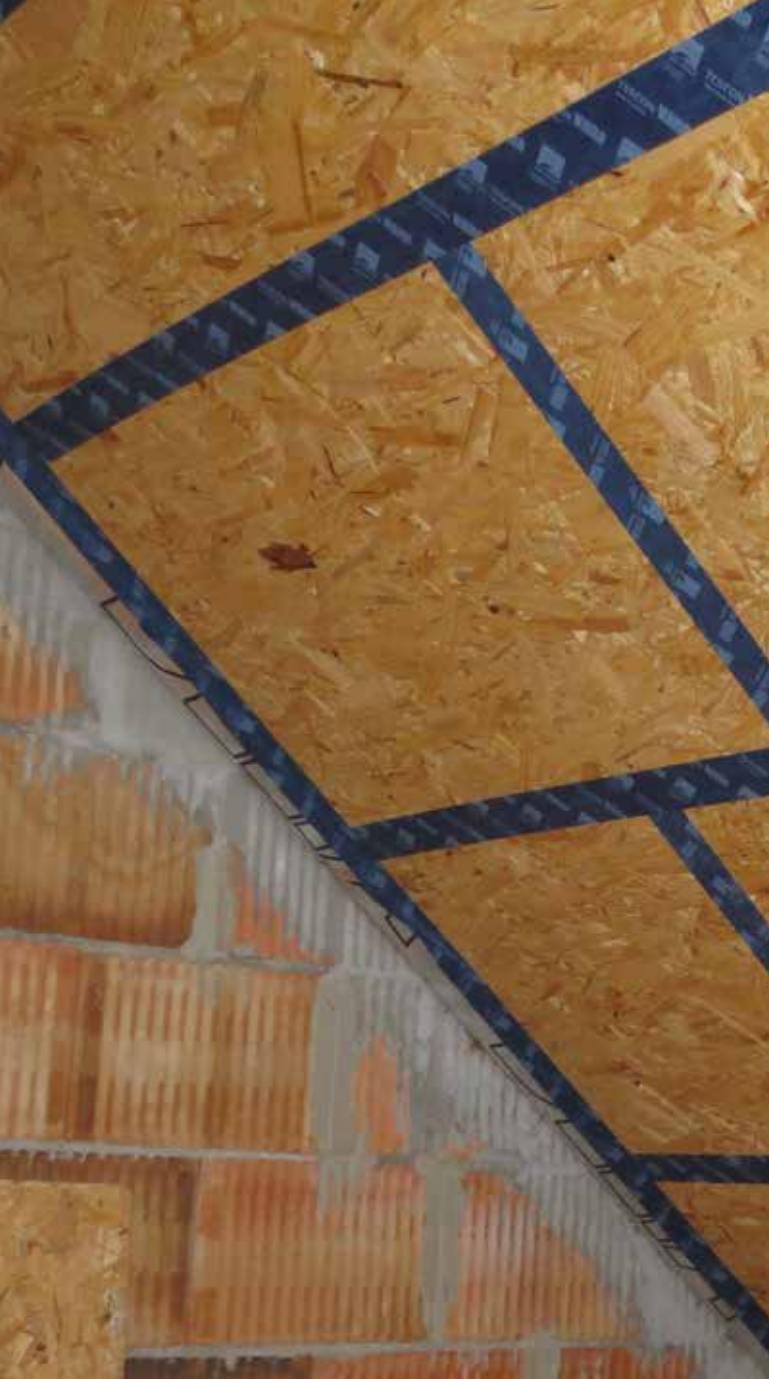
Abb. 2a – Reaktion von Baustoffen auf Feuchte: Bei erhöhter Luftfeuchtigkeit müssen geeignete Klebebänder verwendet werden. Ideal sind dabei wasserfeste Feststoffkleber aus Reinacrylat.
