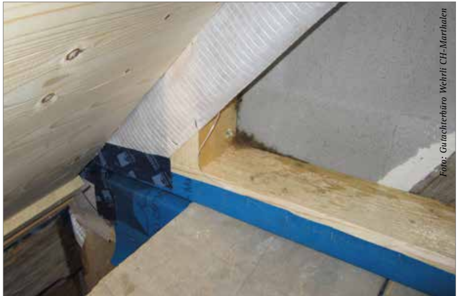
Durchgängige Luftdichtung am Deckenaufleger
