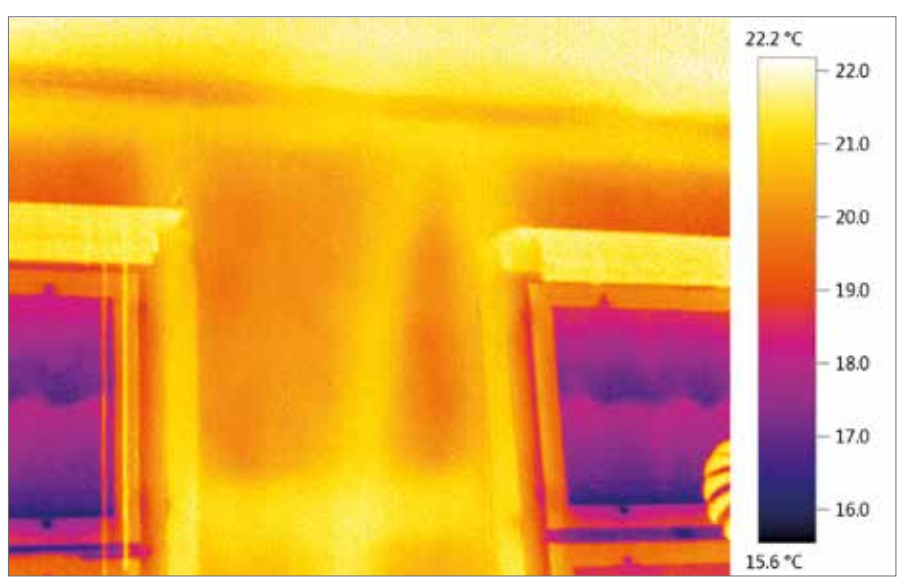
Thermografie Aussenwand: Thermografie einer Fachwerkwand vor der Sanierung
