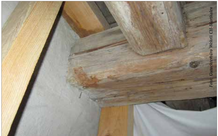
Balkenkopf mit Riss: Riss in Balkenköpfen können eine Leckage darstellen
