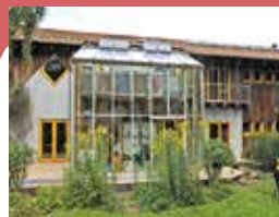
③ Energie- und Umweltzentrum am Deister e. V. Zum Energie- und Umweltzentrum 1 31832 Springe-Eldagsen
