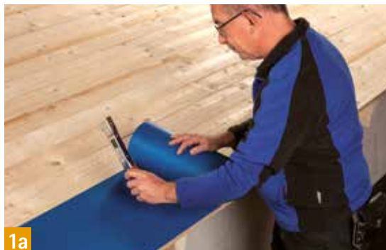
SOLITEX WELDANO-S Diffusionsöffener, wasserdicht verschweisbarer Unterdach- bahnstreifen
