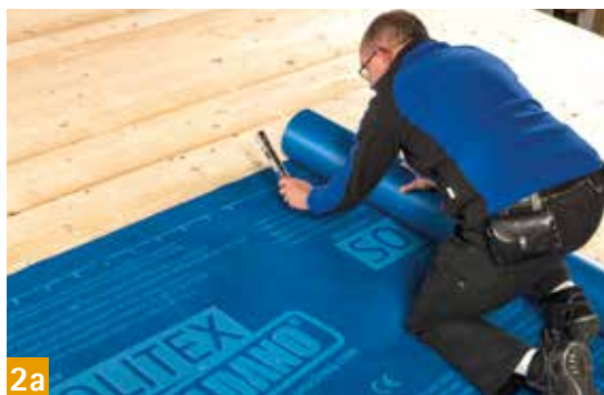
SOLITEX WELDANO Diffusionsöffene, homogen verschweisbare Unterdachbahn
