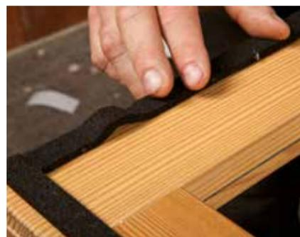
Band umlaufend auf den Blendrahmen kleben. Dabei pro Seite je einen Zuschnitt CONTEGA FIDEN EXO verwenden und die Ecken stumpf stoßen. Im Eckbereich leicht stauchen.
