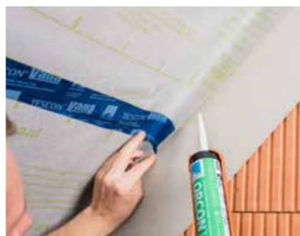
Anschlusskleber für Luftdichtungsbahnen innen,
