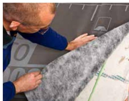
... Winddichtungsbahnen außen,
