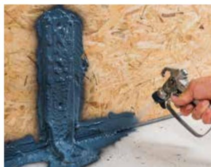
Luftdichtes Übersprühen von Befestigungswinkeln,
