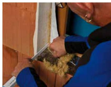
Fenster einsetzen und Fuge dämmen
