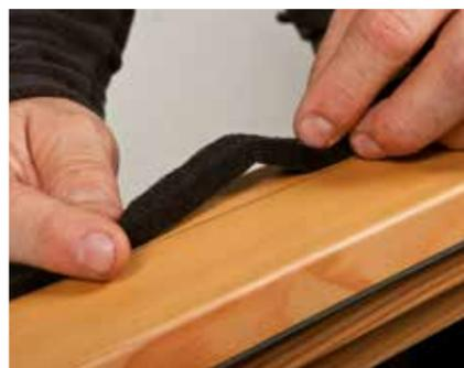
Band beim Aufkleben und besonders im Bereich von Stößen leicht stauchen – keinesfalls dehnen!
