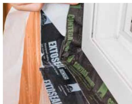
In Ecken luft- bzw. schlagregendicht verkleben.
