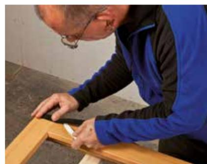
Trennfolie lösen und Band gerade am Blendrahmen ausrichten und Zug um Zug aufkleben. Das Band darf nach dem Einbau nicht sichtbar sein (Rücksprung ca. 1 - 2 mm).
