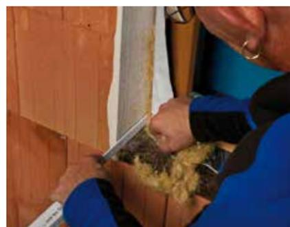
Fenster einsetzen und Fuge dämmen
