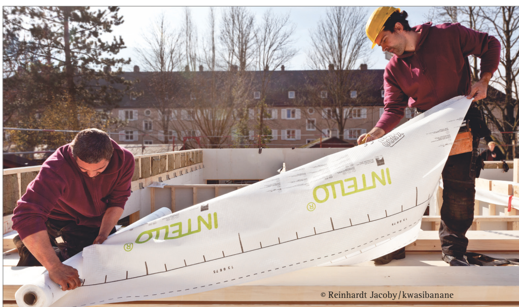
Sicherheit mit intelligenten Dampfbremsen: Bei Flachdächern in Holzbauweise kann durch Einsatz feuchtevariabler Dampfbremsen die Innenoberfläche zur Rücktrocknung aktiviert werden – auch unvorhergesehen auftretende Feuchtigkeit kann im Sommer wieder nach innen austrocknen.
