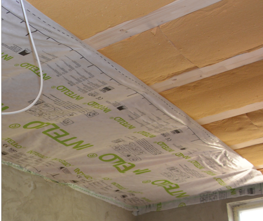
Flachdächer in Holzbauweise mit Volldämmung sind bauphysikalisch sehr anspruchsvoll: Genormte und nachgewiesene dauerhafte Lösungen bieten Verarbeitern Sicherheit bei der Ausführung.
