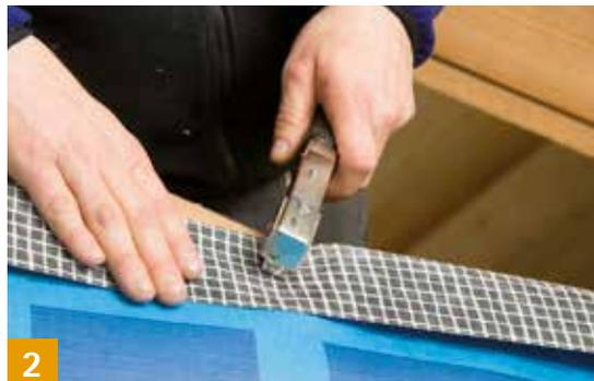
verkleben. Bahn parallel zur Traufe ausrollen und mit mind. 10 mm breiten und 8 mm langen verzinkten Tackerklammern feuchtegeschützt im Überlappungsbereich befestigen. Bahn ca. 4 cm auf angrenzende Bauteile führen, damit hier später winddicht angeschlossen werden kann.
