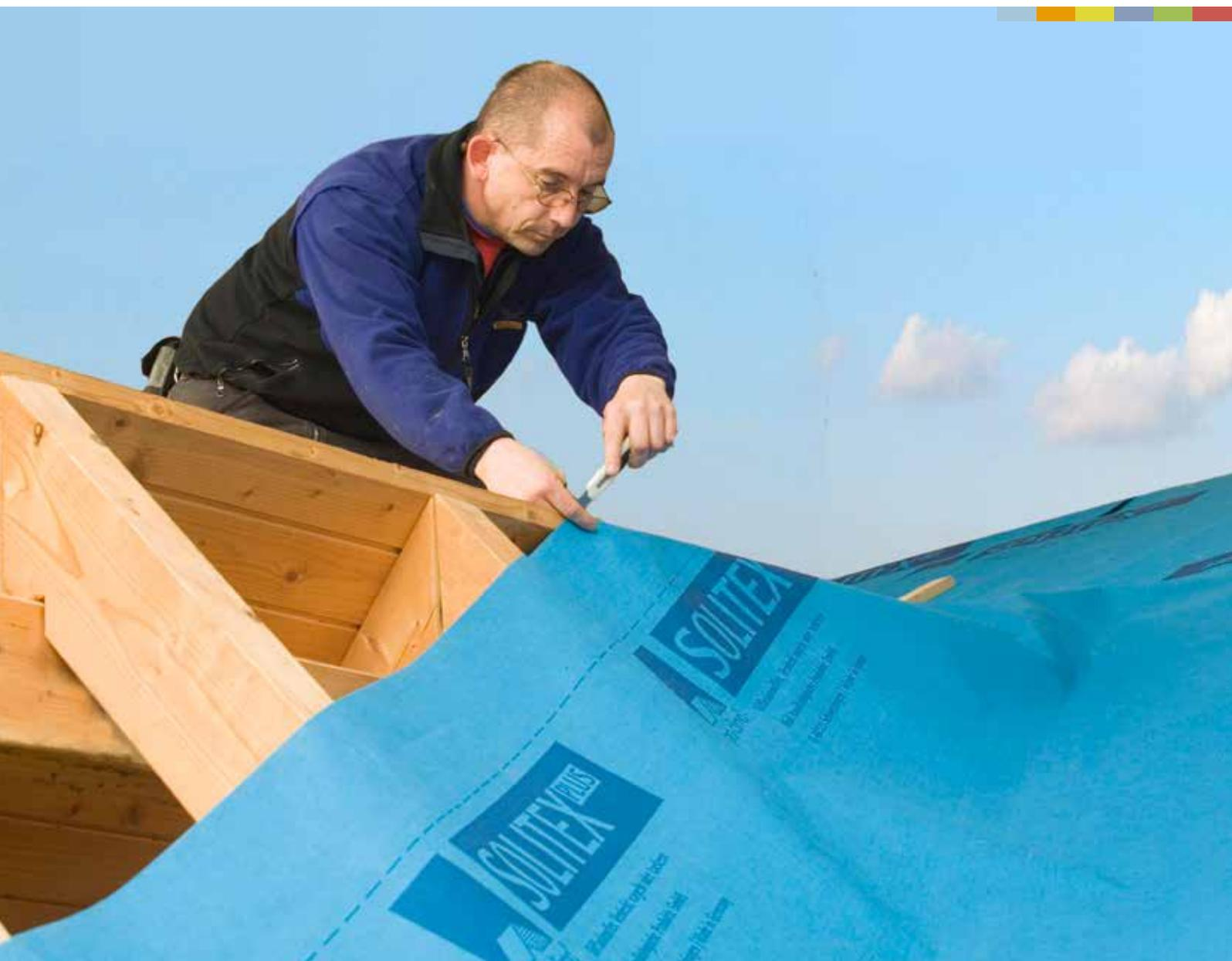
Unterdach-System mit hochdiffusionsoffener Unterspannbahn pro clima SOLITEX PLUS
