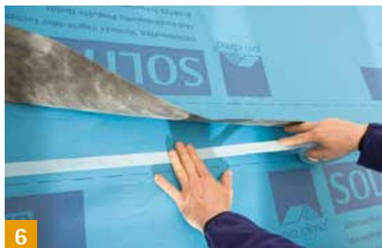
Bahnen ohne Selbstklebezonen können feuchtegeschützt mit dem doppelseitigen DUPLEX verklebt werden. Einfaches Verarbeiten ist mit dem DUPLEX Dispenser möglich. Andrücken, abrollen, ablängen in einem Arbeitsgang.
