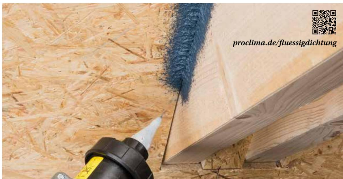
AEROSANA VISCONN lässt sich per Pinsel, Airless- oder Druckluftsprühen auftragen
