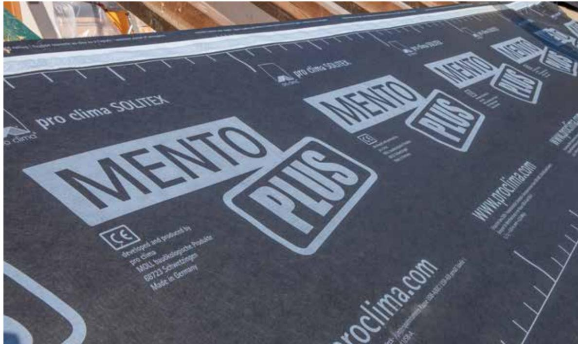
Die Unterspannbahnen der SOLITEX MENTO-Serie sind extrem alterungsbeständig, dicht und diffusionsoffen: Der monolithische SOLITEX-Funktionsfilm schützt die Dämmung perfekt von der Außenseite her
