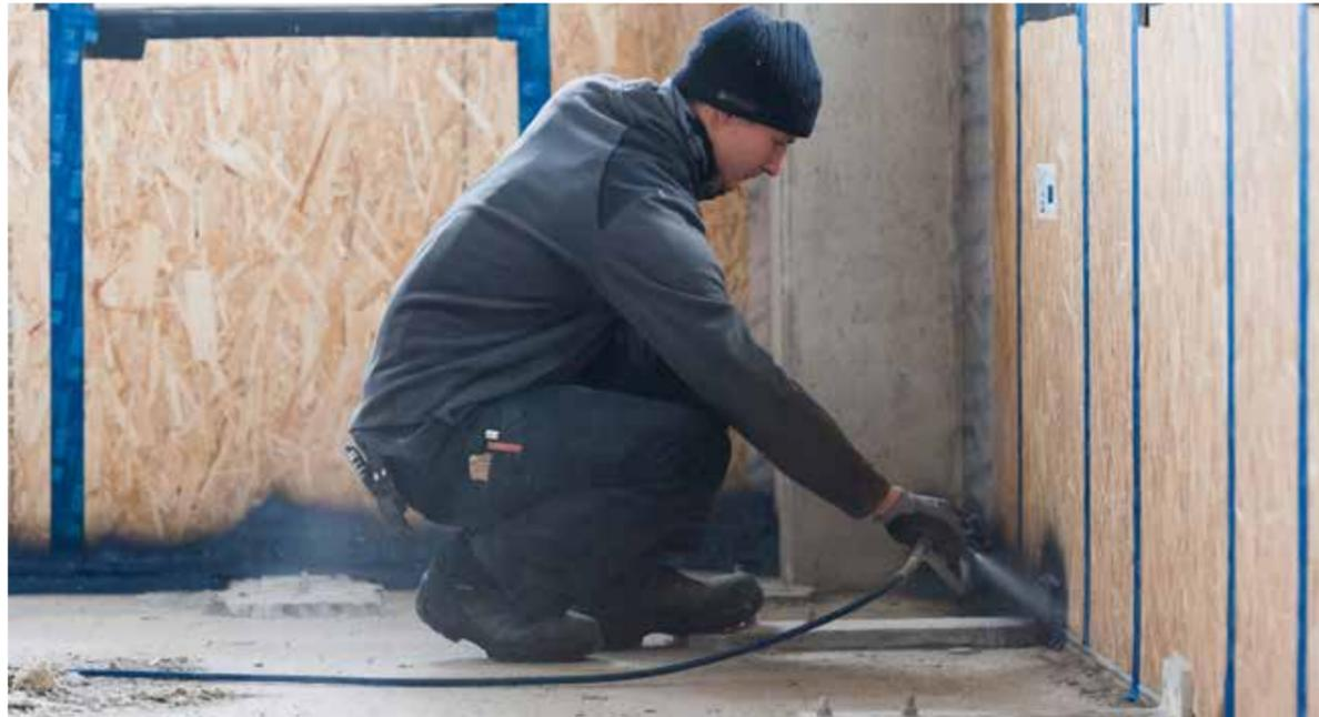
Die sprühbare Luftdichtung ist extrem zeitsparend, vielseitig einsetzbar und besonders für schwierige Anschlüsse geeignet
