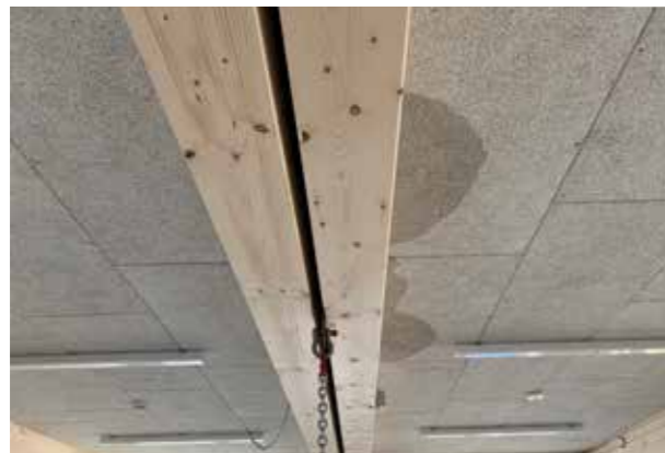
Undichter Modulstoß
