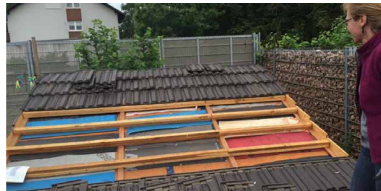
Teststand mit Unterdachbahnen verschiedener Hersteller: Öffnung 5 Jahre nach dem Einbau
