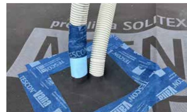
pro clima Manschetten und TESCO VANA Allround Kleband wurden eingesetzt, um Durchdringungen für Kabelrohre (mit ROFLEX 20 multi) ...
