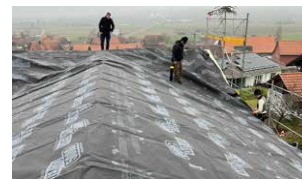
Ausgelegte Unterdachbahn SOLITEX MENTO 5000 connect
