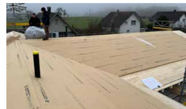
Anlieferung der vorkonfektionierten Plane zum Verlegen auf Holzfasernerunterdachplatten
