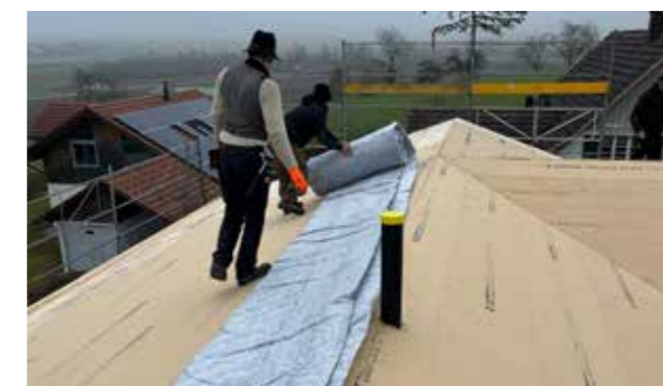
Ausrollen der vorkonfektionierten Plane
