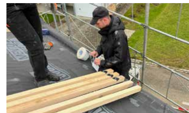
TESCON NAIDECK mono patch Klebe-Pflaster dienen als Nagel-dichtungen zwischen den Konterlatten ...
