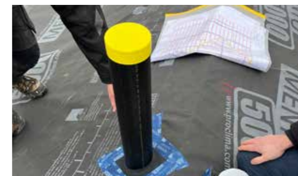
... und Dunstrohre (mit ROFLEX 100) abzudichten
