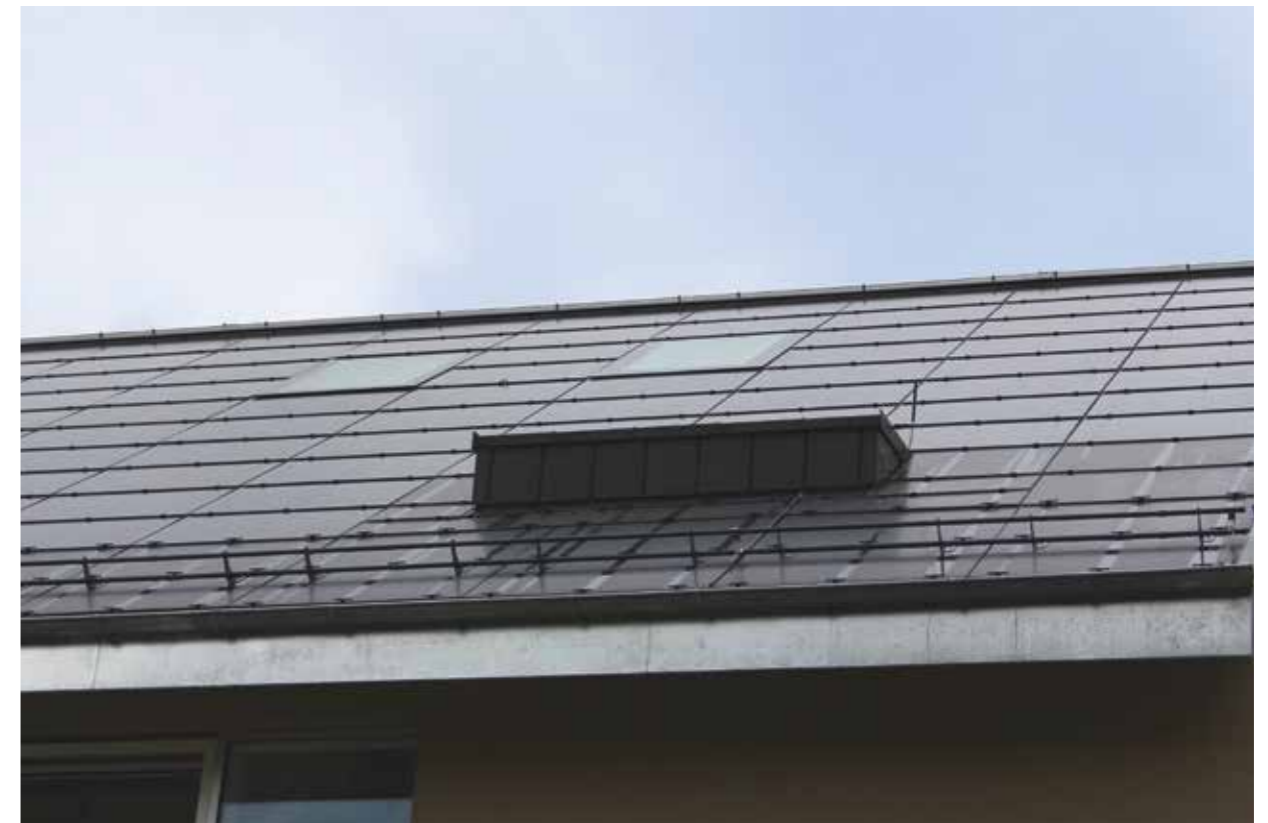
Integrierte PV-Anlage mit Unterdach SOLITEX MENTO 3000 connect
